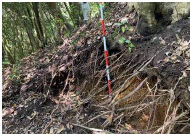
ふるゆ 古湯地区に発生した亀裂
