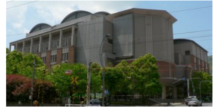
長崎ブリックホール
