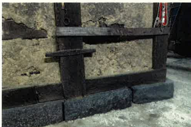
基礎石 (もと蔵と同じものを使用)
