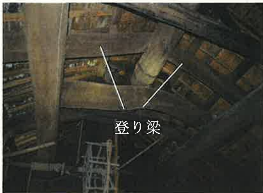
写真② 貯蔵蔵 小屋組
