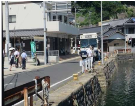
勝本港 （作業スペース不足、転落の危険性）
