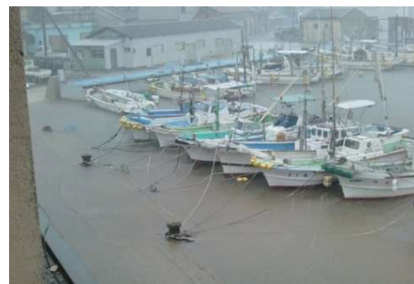
度島漁港 （-2m物揚場の浸水状況）
