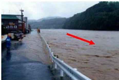
川棚川 江川橋上流
