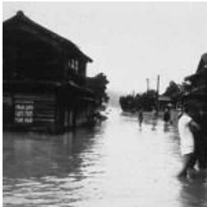
県道川棚有田線 石木地区付近
