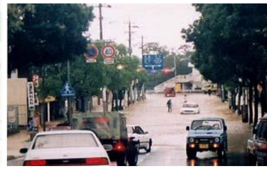
川棚駅前交差点の浸水状況 (H2.7撮影)
