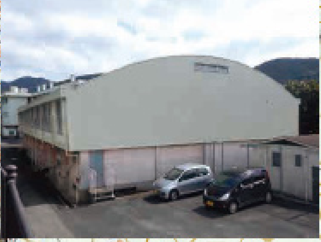
⑭ 川棚中学校体育館
