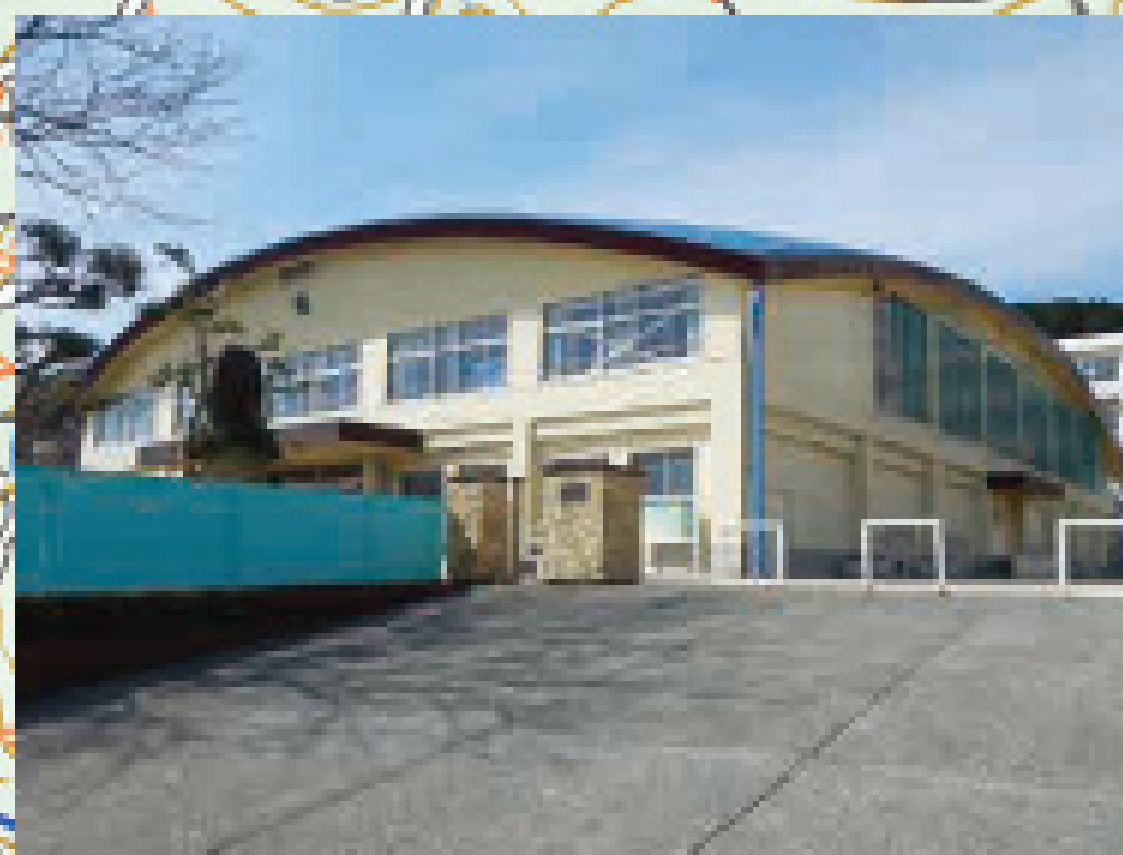
㉔ 川棚中学校体育館
