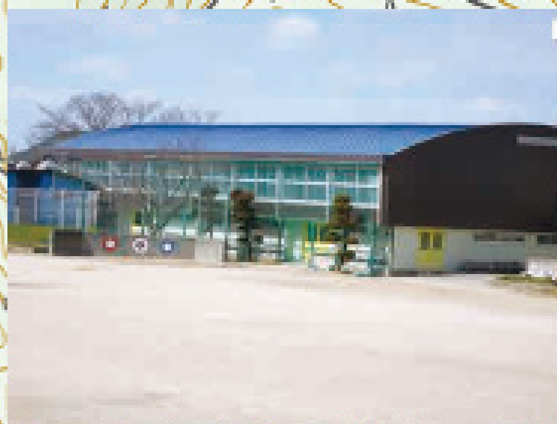
⑫ 小串小学校体育館
