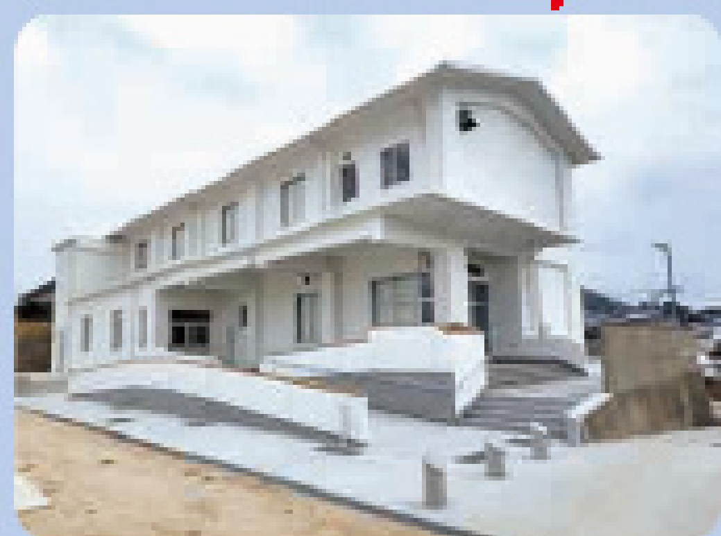
長島地区放射線防護対策施設
