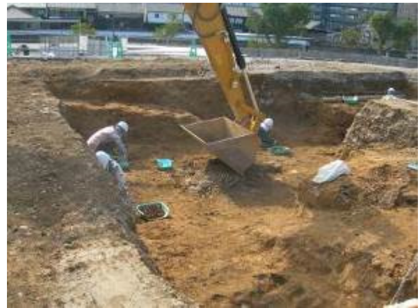
写真 14 TP7 状況（北から）
