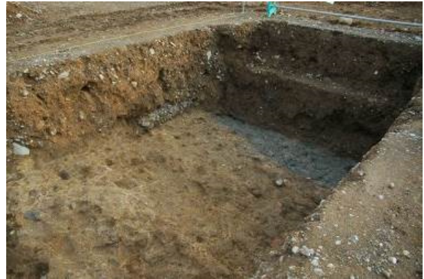
写真 23 TP11 溝状落ち込み完掘状況（西から）
