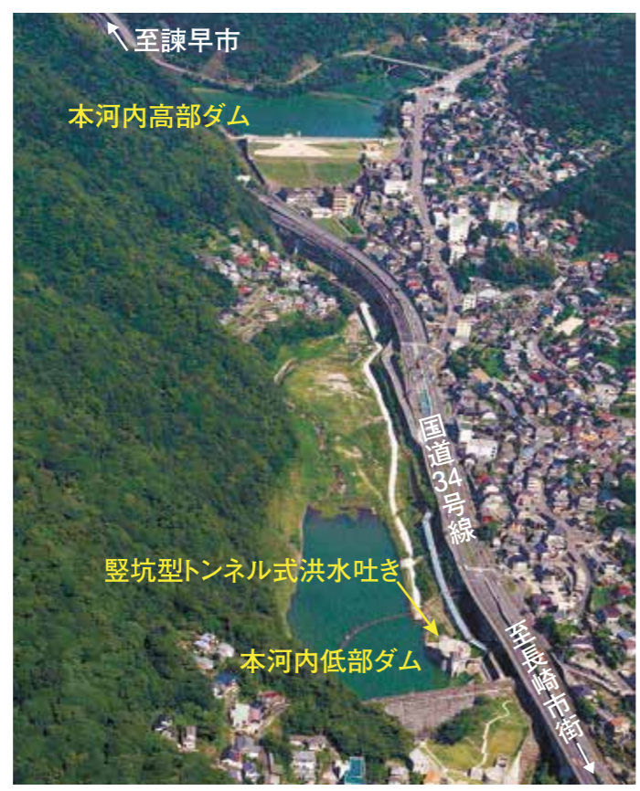
本河内高部ダム・本河内低部ダム航空写真
