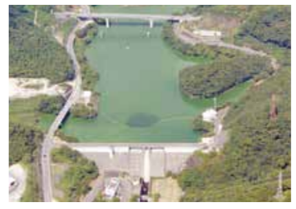
中尾ダム(平成12年完成) (長崎市田中町に新設)
