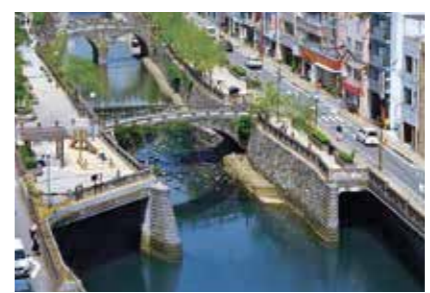
改修が終わった中島川 【両岸バイパス水路】
