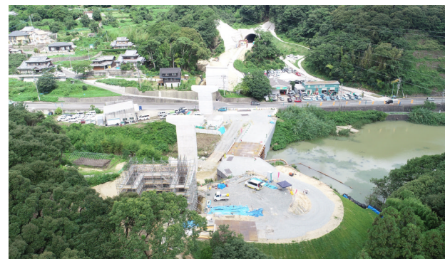
【写真】時津工区 左底高架橋施工状況
