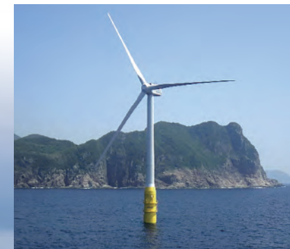
五島市崎山漁港の沖合にある国内初の浮体式洋上風力発電設備のメンテナンスも行う
