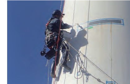
風車の高さは地上から羽の先端までで120m。ロープワーク専門チームを組成して業務に当たる
