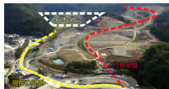
石木ダム建設事業(川棚町)
