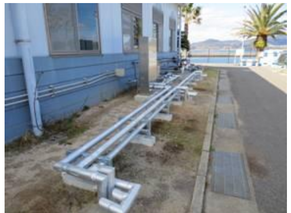
試験区1に設置した地中熱ヒートポンプシステム
