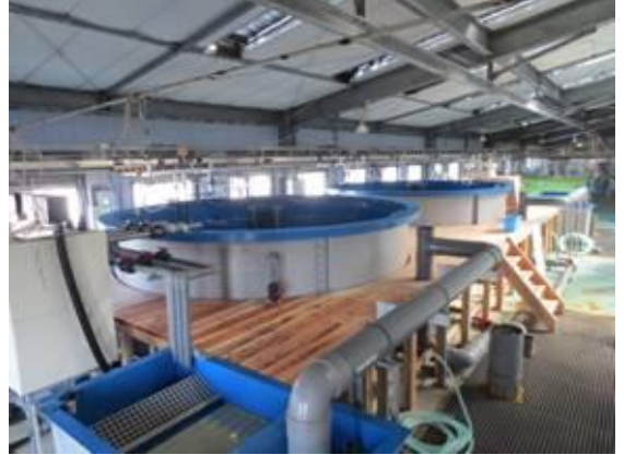
20 t 飼育水循環型陸上水槽 (試験区1、2)
