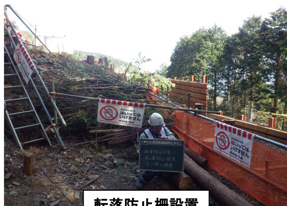
転落防止柵設置
