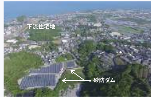
鮎川砂防ダム
