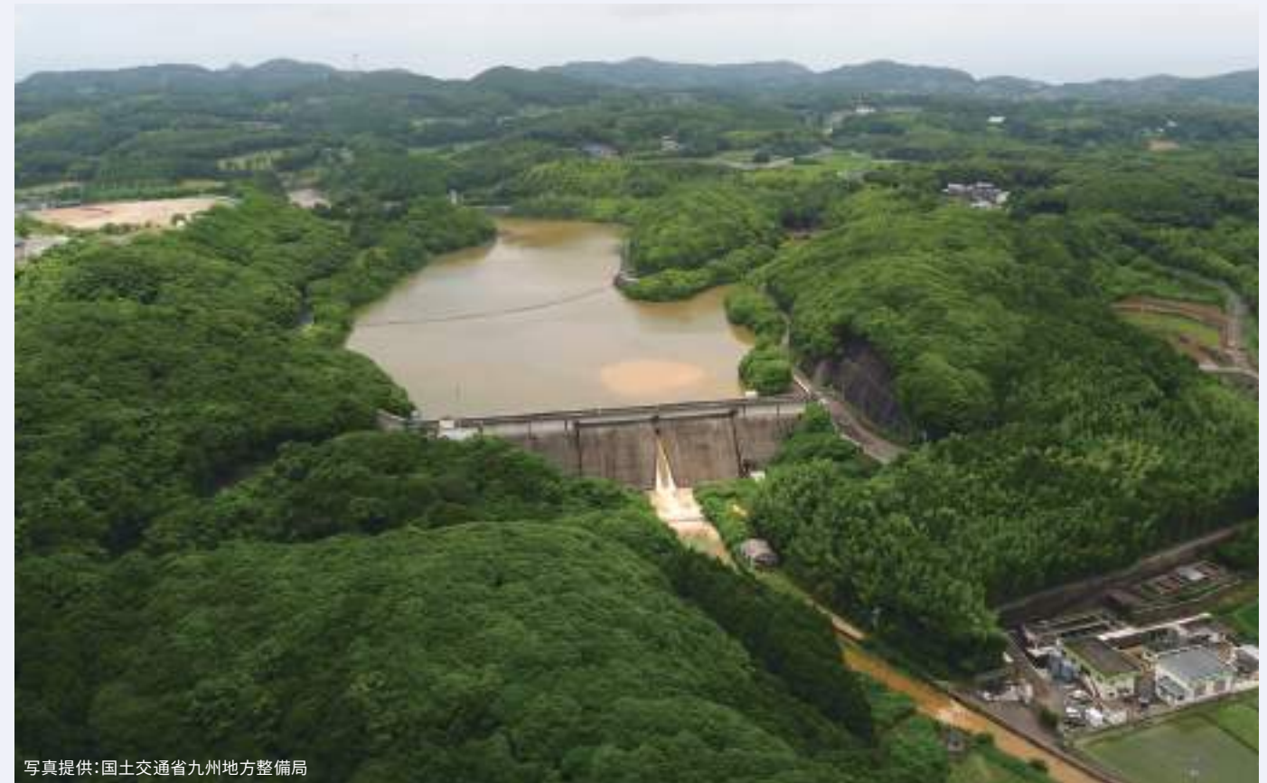
最大で毎秒60トンの流入に対し、ダムで毎秒45トン貯め込み洪水調節を行った勝本ダム(壱崎市勝本町 H29.6.30)
