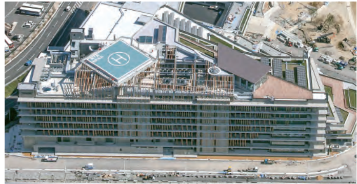
行政棟、議会棟、警察棟は、免震構造(駐車場棟は耐震構造)を採用するとともに、ヘリポートの設置や災害時における水、電気、ガスのライフライン確保対策もとっています(写真上は免震装置、写真下は行政棟のヘリポート)
