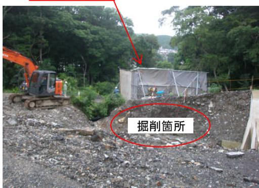
飛散防止のため作業員及び第三者の立入を禁止し、重機作業半径10m程度の位置に高さ2～3mの飛散防護シートを設置する。
