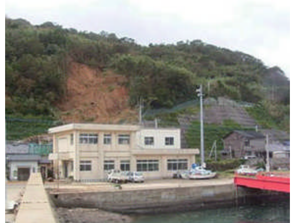
人家裏の斜面が崩壊（平成18年 五島市）
