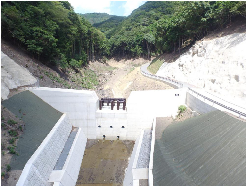
一重川通常砂防事業(3号堰堤) (平成27年8月竣工)
