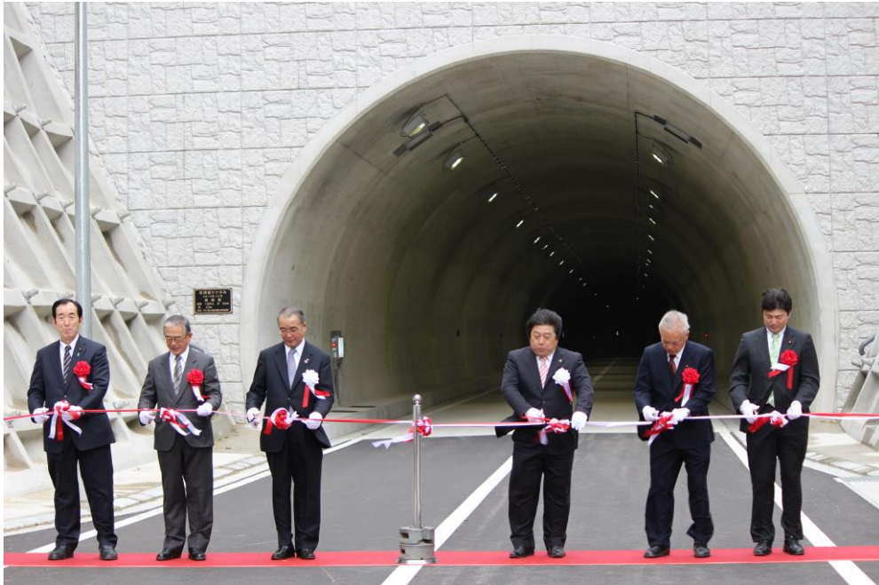
主要地方道 棧原小茂田線 佐須坂トンネル供用開始(平 28.2.14)
