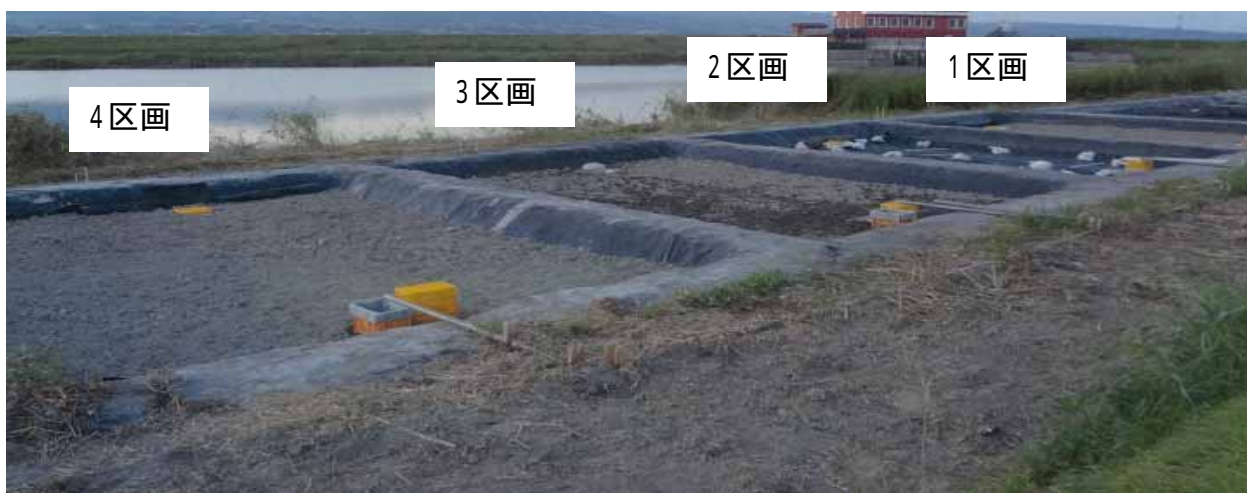
a) 土壌浸透浄化施設全景
