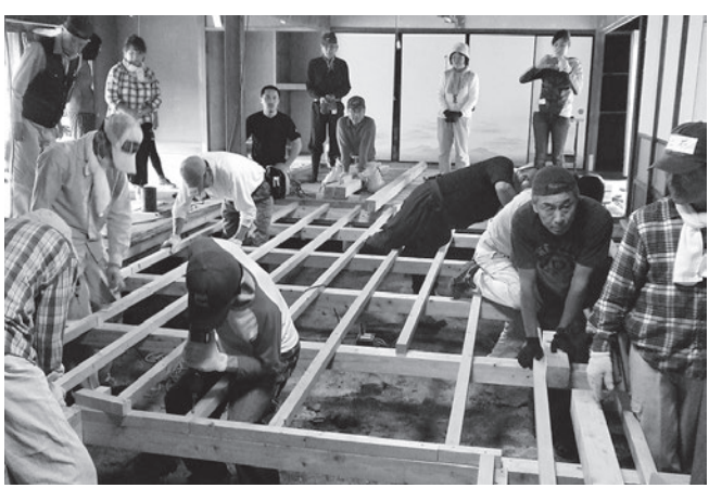
棟梁の指示を受け、床下部分のはめ込み作業を参加者が行う。
