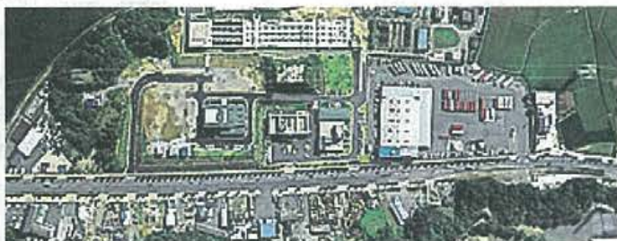
< 大村湾南部浄化センター >
