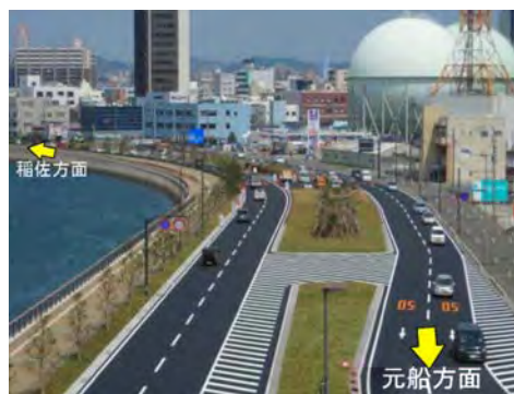
写真－８＜浦上川線と左岸プロムナード＞
