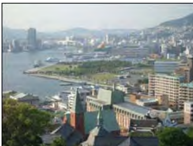
写真-14 〈長崎港内港地区全景〉
