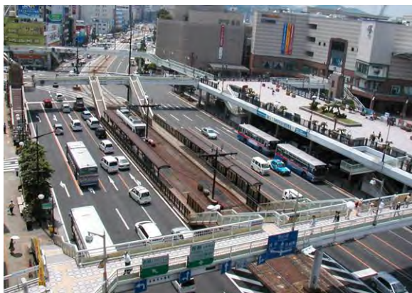
写真-10 <国道202号(長崎駅前電停)の現状>
