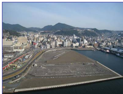
写真-12 県庁舎建設予定地（長崎魚市跡地）
