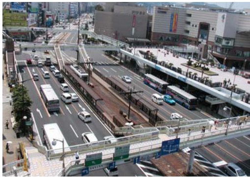
写真-10<国道202号(長崎駅前電停)の現状>
