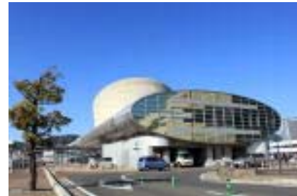
写真－６＜長崎港ターミナル＞
